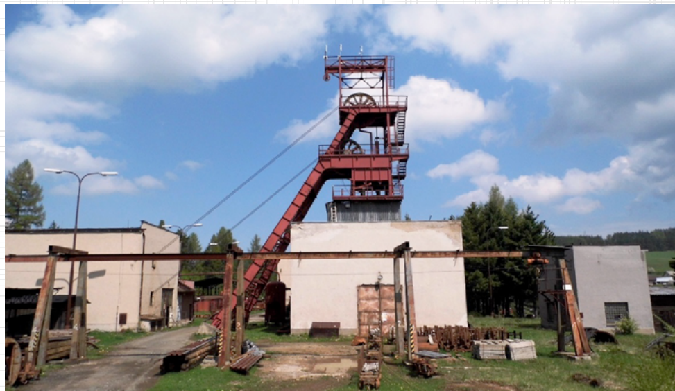
Strojovňa, ťachtová budova s vežou a ventilátorovňa jamy
